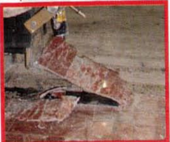
Entfernen von Fliesen
